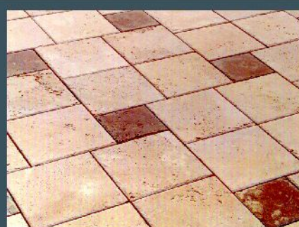
Pavimento in travertino Noce e Classico, spazzolatura manuale
